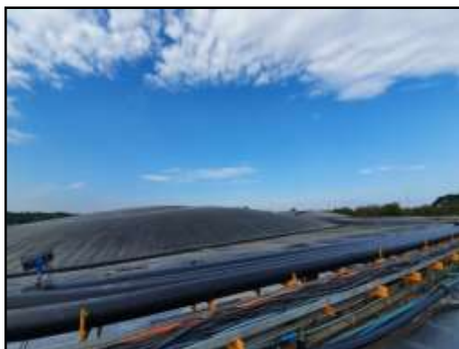
รูปที่ 2-7 บ่อหมักของระบบผลิตก๊าซชีวภาพ ของโครงการ
