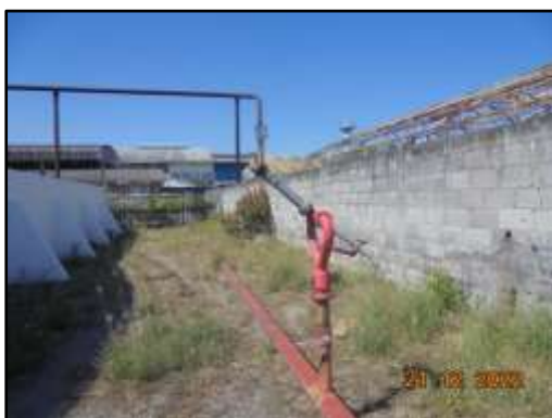
รูปที่ 2-35 ท่อน้ำดับเพลิงโดยรอบพื้นที่ส่วนผลิตและถังเก็บเอทานอล
