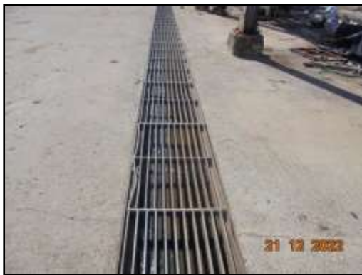
รูปที่ 2-17 รางระบายน้ำฝนรอบพื้นที่โครงการ
