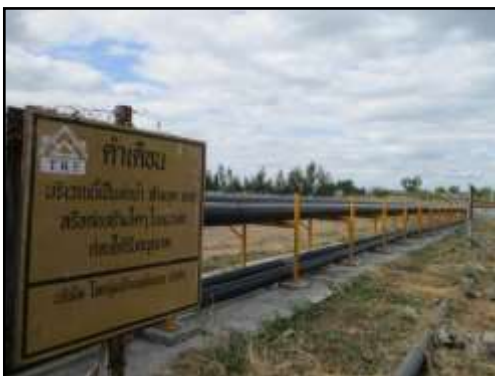
รูปที่ 2-38 ท่อที่ใช้ในการลำเลียงก๊าซชีวภาพของโครงการเป็นท่อ HDPE PE100/PN10
