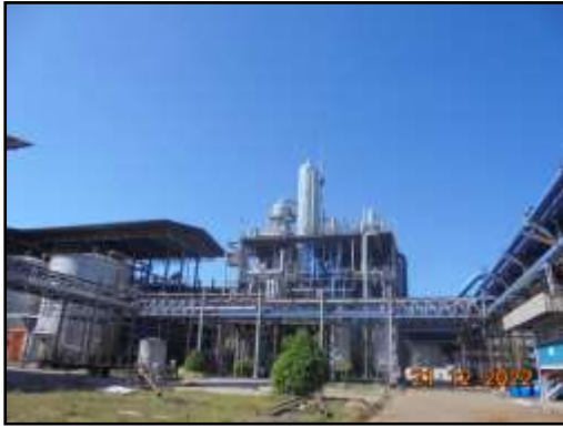
รูปที่ 2-9 ถังหมัก หอกลิ้น และหอกลั่นน้ำที่เป็นระบบปิด
