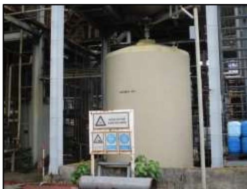
รูปที่ 2-39 ถังเก็บ NaOH
